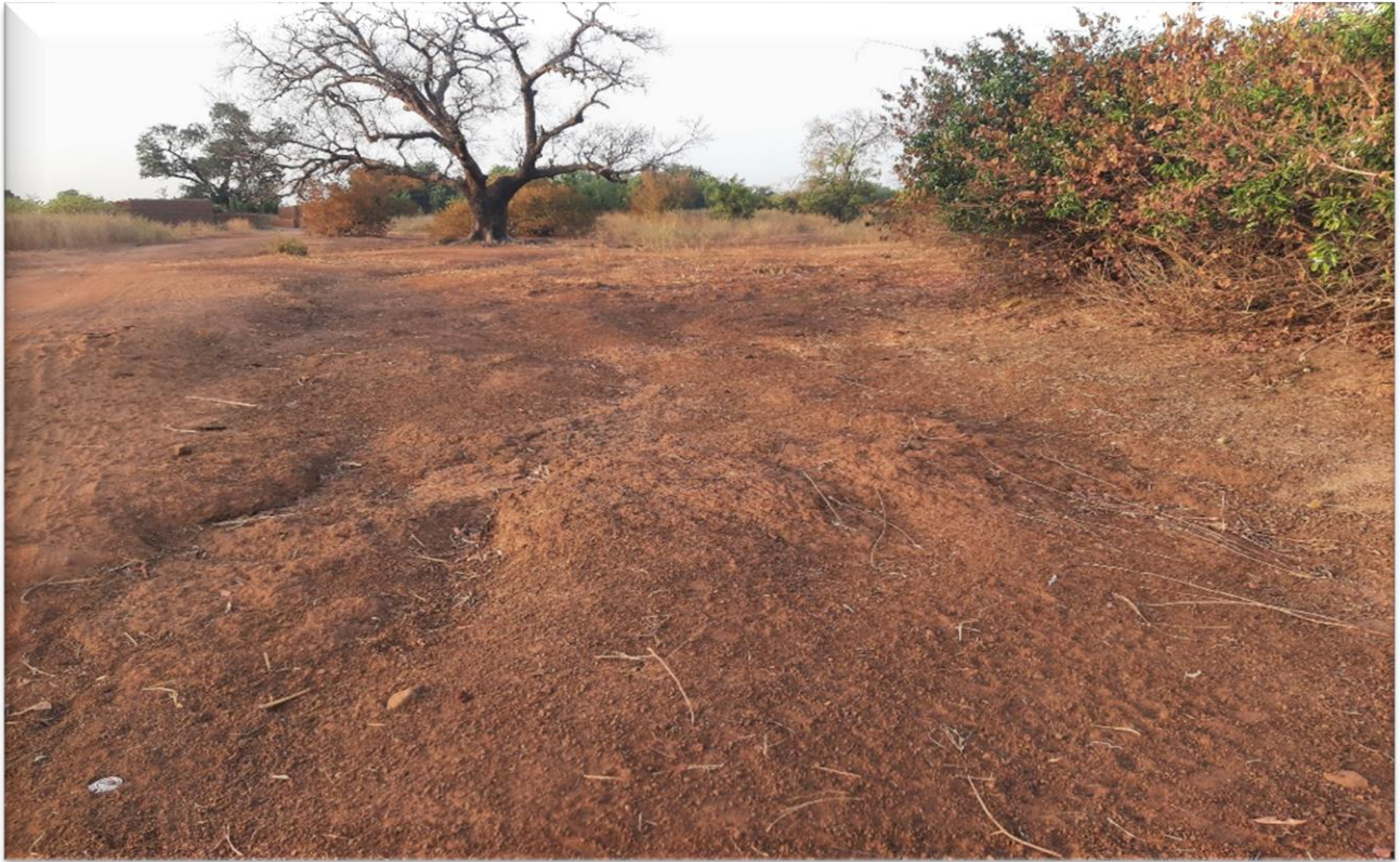
Photo 5: Etat de la piste existante : affleurement de cuirasse latéritique
