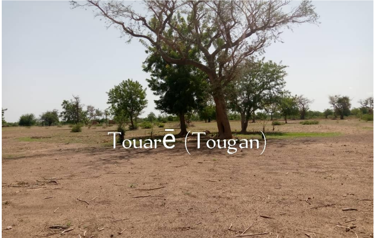
Photographie 1: Site de construction du CSPS de Touaré
