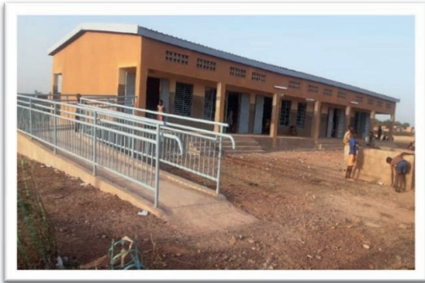
Construction de salles de classe au secteur 7 de Tougan
