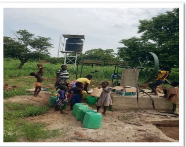
Forage communautaire avec système de pompe solaire sur le
