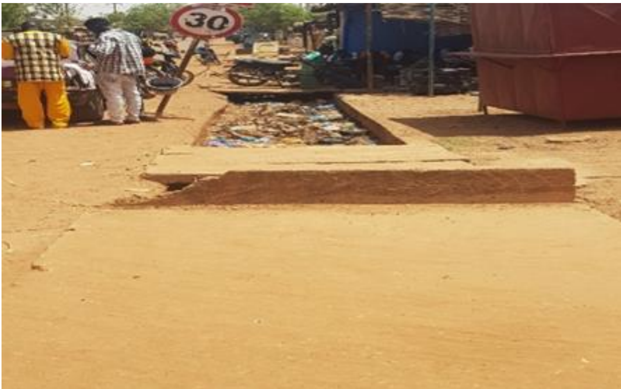
Photo 3 : Aperçu de l'état actuel du réseau d'assainissement de l'itinéraires 2.2
