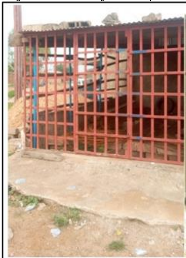
Hangar en tôles entouré de grille métallique
