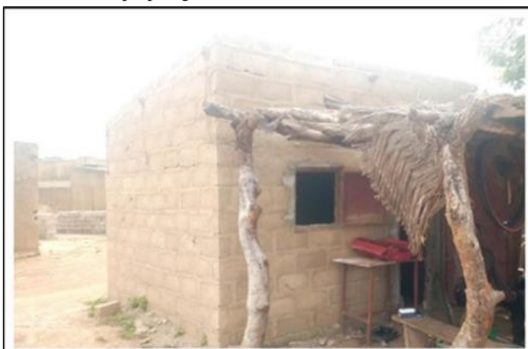
Maison en parpaing servant de commerce
