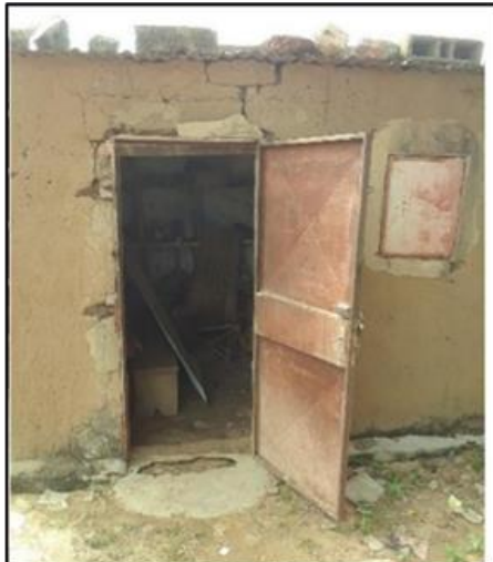
Maison en banco servant de commerce
