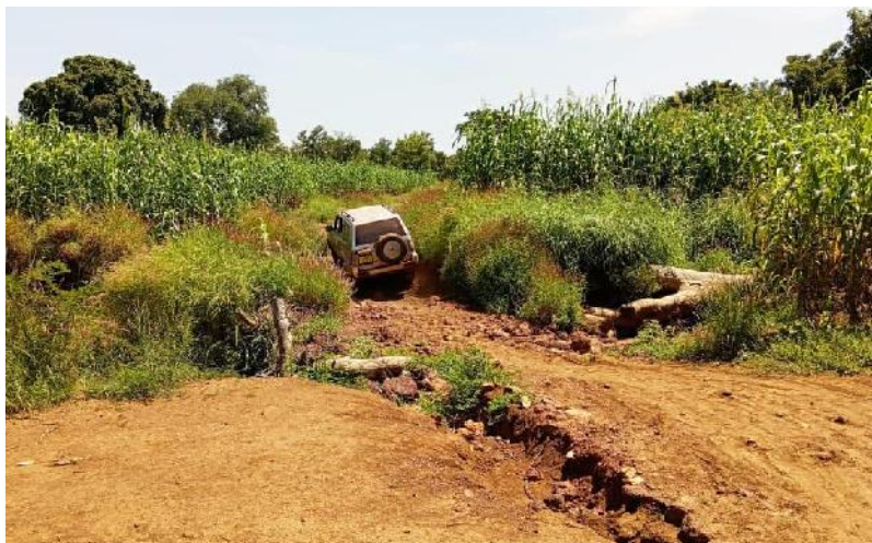
Figure 22: : piste dégradée dans la commune de Poura
