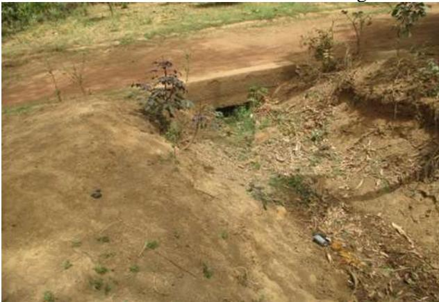
Dalot de passage des eaux sauvages partiellement bouché au départ du FS4
