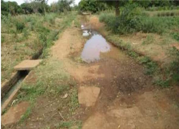
Dégradation d'un tronçon de la piste longeant le canal primaire B en rive gauche
