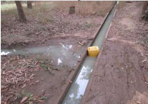
Blocage d'eau d'irrigation sur le CS4 et la déviation Pour l'irrigation de parcelles informelles
