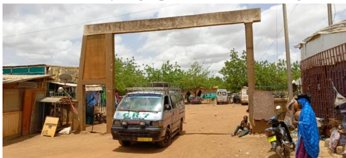
Entrée de la gare
